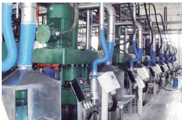
Автоматическая линия производства красок
