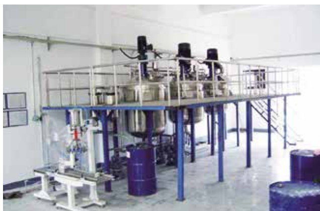
Автоматическая линия производства красок
